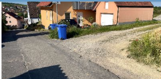
Verlängerung Hauptkanal & Erschließung Steigstraße 27 in Maidbronn
