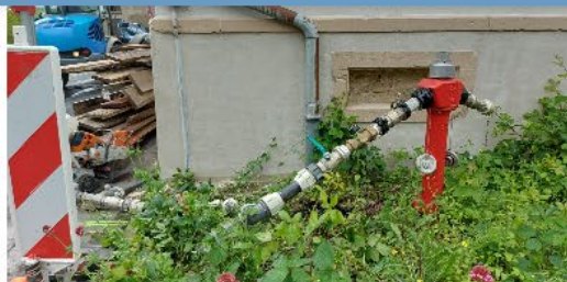
Grabenlose Wasserleitungssanierung „Zur Veitsmühle“
