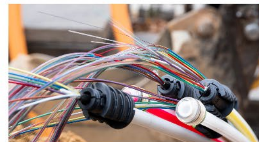
Glasfaserausbau Markt Rimpar
